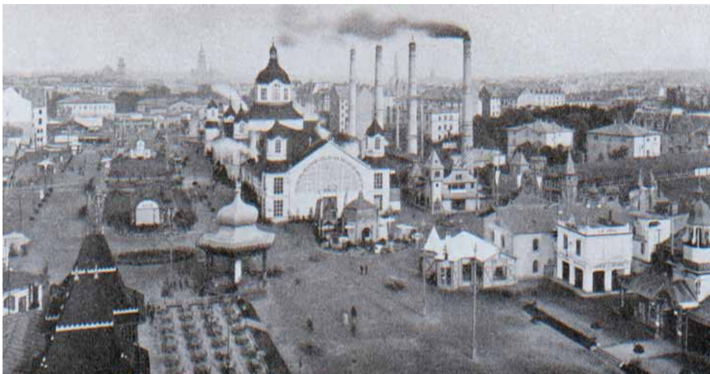
Abb. 2: Internationale Elektrotechnische Ausstellung Frankfurt am Main 1891
