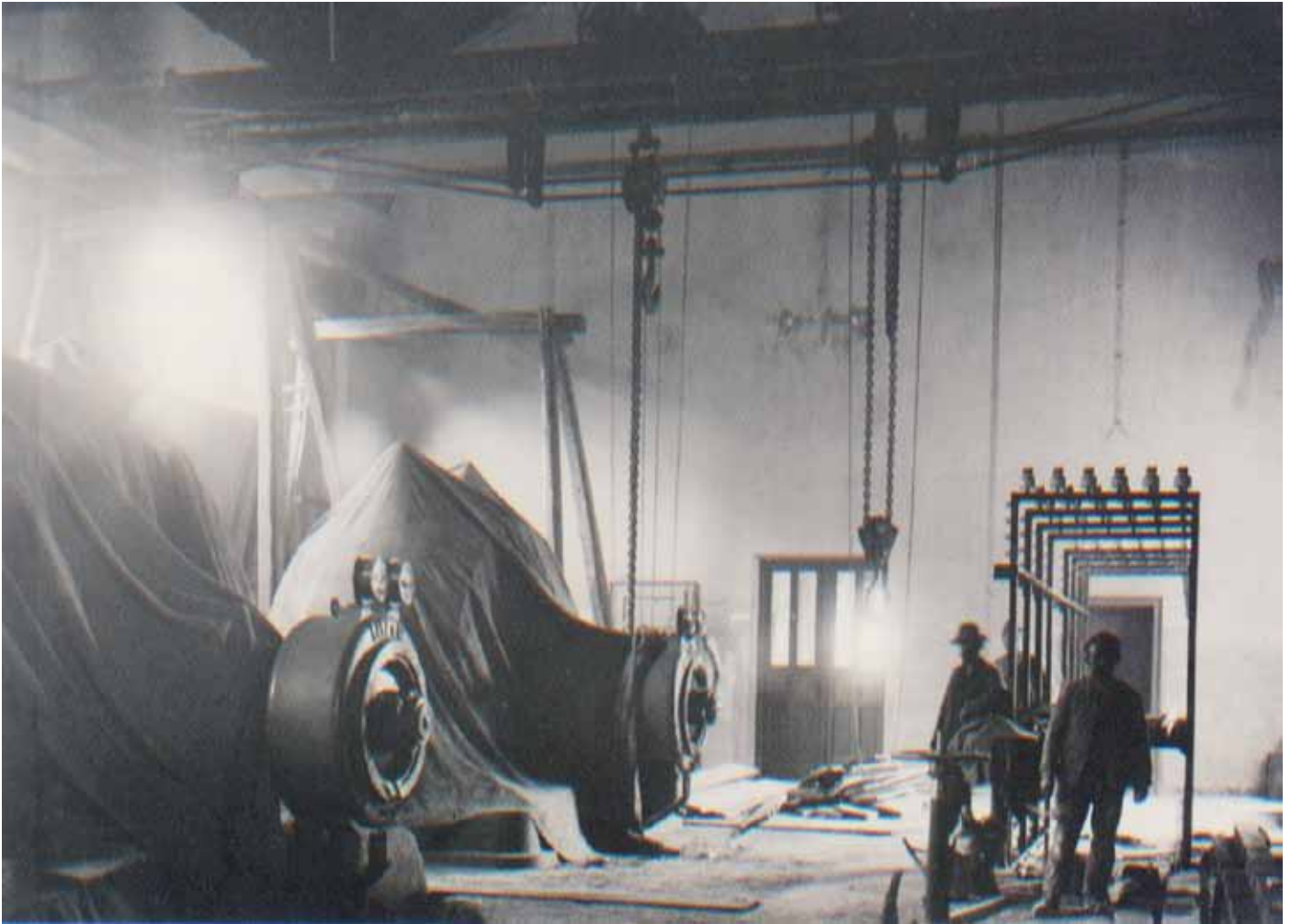
Abb. 5: Krafthaus Töll der Etschwerke. Einbau der Turbinen von Ganz & Co. in Budapest, 1897
