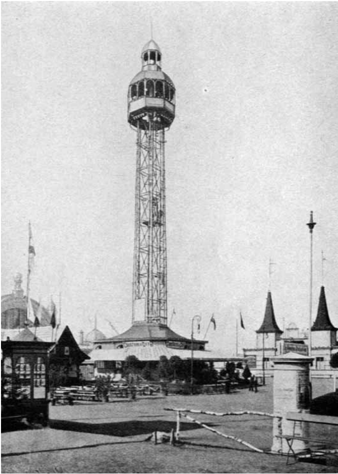
Abb. 4: Internationale Elektrotechnische Ausstellung Frankfurt am Main 1891, 45 Meter hoher Turm in Eisenkonstruktion mit elektrischem Aufzug
